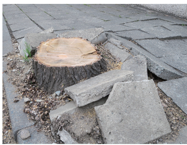
歩道損傷箇所の樹木を伐採
