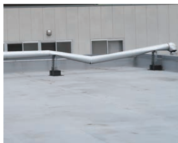
雪の重みで屋上配管損傷
