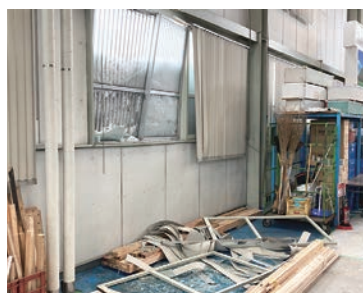
屋根からの落雪で窓破損
