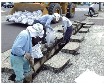
側溝泥上げ作業
